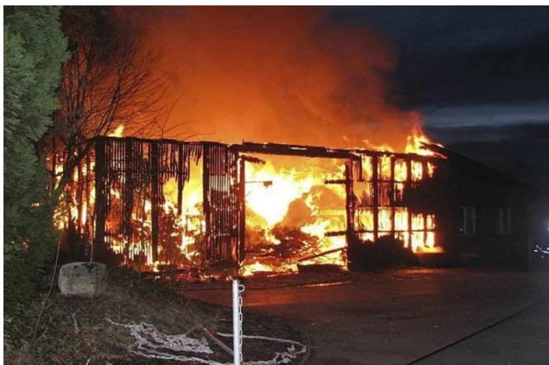
Ein Mehrzweckgebäude in Olsberg brannte komplett ab. (Foto: Kapo AG)
